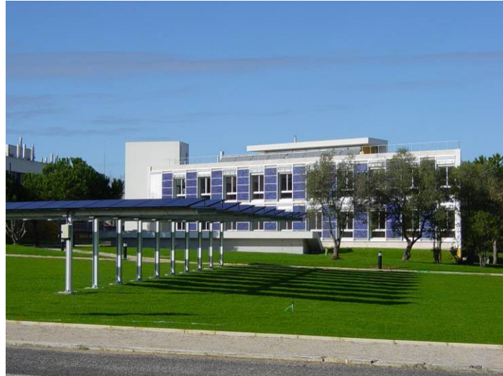
Fig. 1.17 – Sistema fotovoltaico na cobertura do parque de estacionamento e fachada do Edifício Solar XXI, INETI [112]
