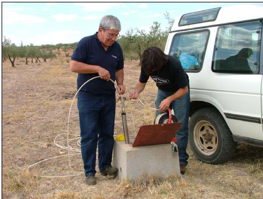
Figura 13.3 – Manutenção no piezómetro Rosa da Lavada (RL).
