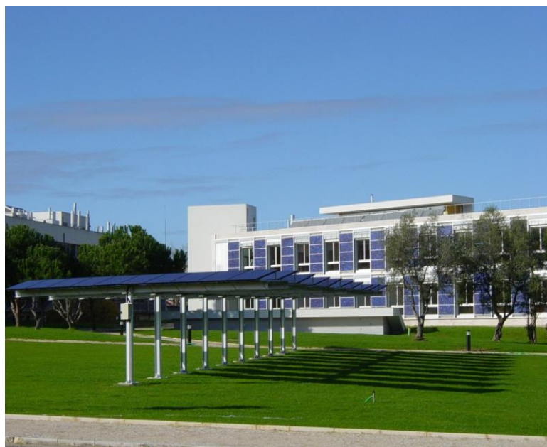
Figura 5 - Fachada Sul do Edifício Solar XXI do LNEG vista do parque de estacionamento também ele coberto com painéis PV.
