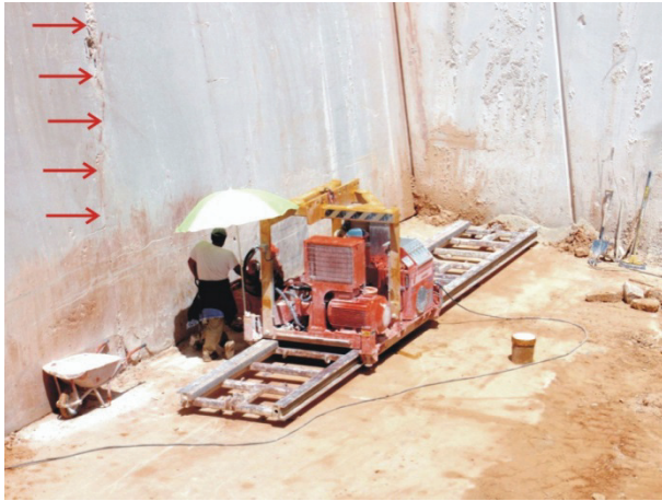
Figura 17 – Pedreira Valinho do Curral nº 2. Nível inferior da pedreira, no qual ocorre um calcário cizento azulado, que não forma bancadas bem definidas. Na fotografia, este calcário está situado à direita da fratura subvertical assinalada.
