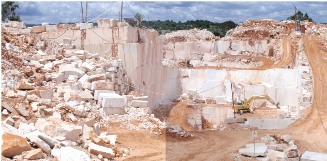
Figura 16 – Pedreira Valinho do Curral nº 2. Vista da frente NW de desmonte (direita da fotografia).
