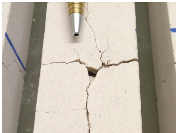
Figura 88 – Detalhe de uma das faces do provete V, do calcário “Crema Fátima”, após resistência ao gelo (48 ciclos). Observa-se fissuração aberta, com perda de material, gerada no decurso do ensaio.
