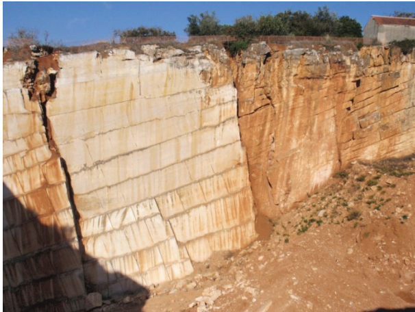
Figura 29 – Pedreira Moleanos nº 3 (Norte). Aspeto da frente de desmorte mais profunda da pedreira (20 m), na qual se podem observar as fraturas denominadas, na gíria extrativa local, por “cabos reais”.
