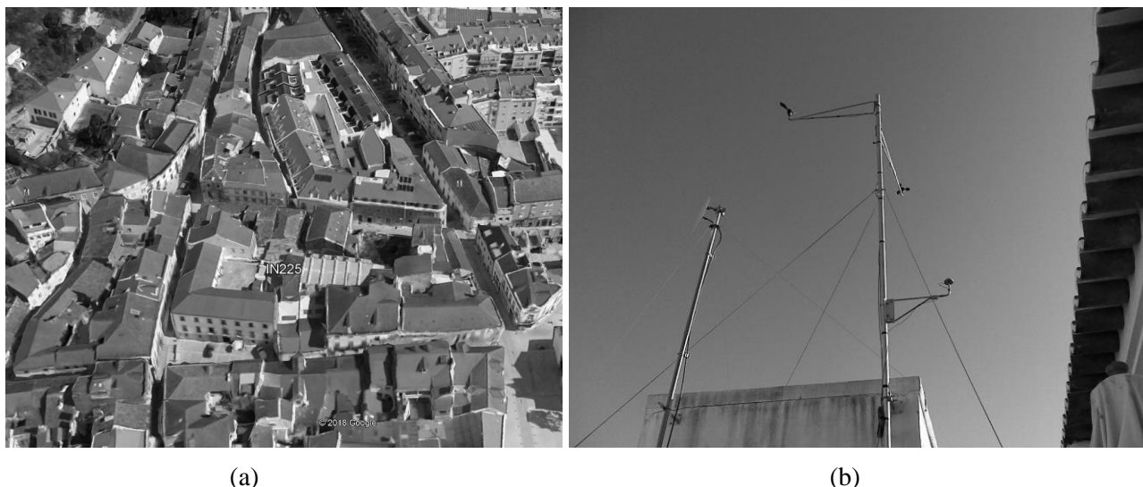
Figura 5. (a) Localização da estação anemométrica no Centro histórico da cidade de Torres Vedras, (b) visualização do sistema de medição do vento
