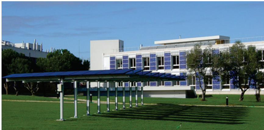
Fig. 1 Plataforma experimental Edifício Solar XXI
