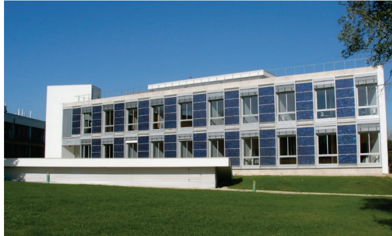
Fig. 1. Edifício Solar XXI
