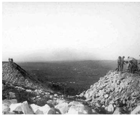
Fig. 5 – Construção de aterro na Serra da Pevide. Foto Match, 1927. AHM – INETI
