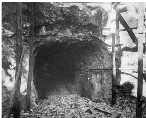
Fig. 4 – Trabalhos de abertura do túnel da Serra da Pevide, hoje parcialmente abatido. Foto Match, 1927. AHM – INETI
