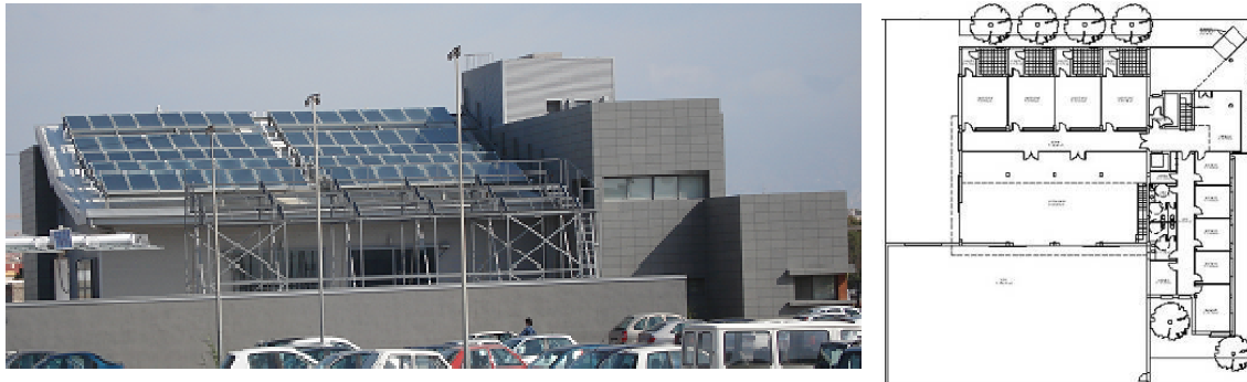
Fig.3. Vista del edificio Ciesol de la Universidad de Almería
