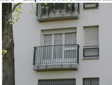
Figura 4 – Vãos envidraçados a nascente.
