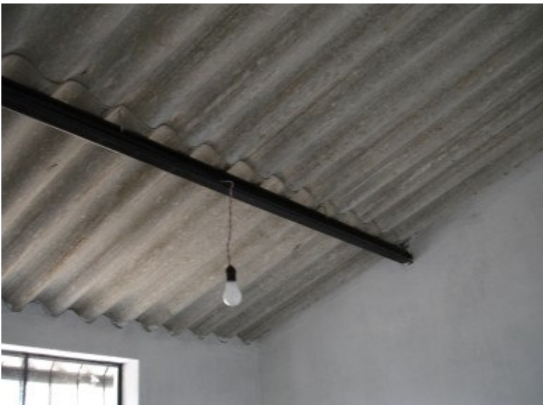
Tumbado e iluminación incandescente
