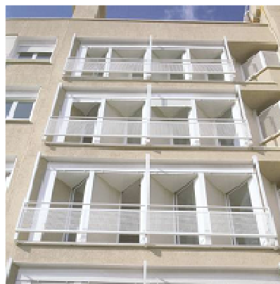
Fig.12. Desplazamiento hacia el sur de los balcones orientados al este, en el bloque de obra nueva.
