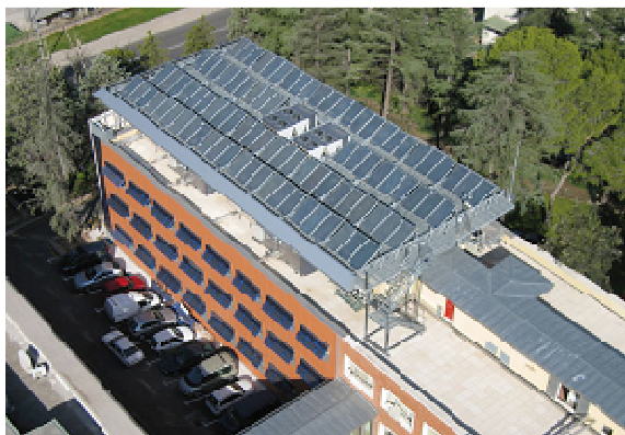
Fig.4. Vista del edificio ED70 del Ciemat, Madrid
