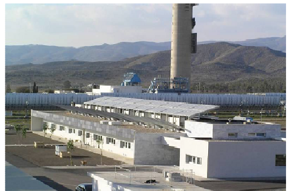
Fig.5. Vista del edificio de la PSA, Desierto de Tabernas, Almería
