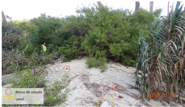
Figura 6. Cones de acumulação de material na base do talude, proveniente da erosão profunda.
