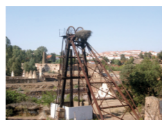
Malacate nº 6 e central eléctrica.
