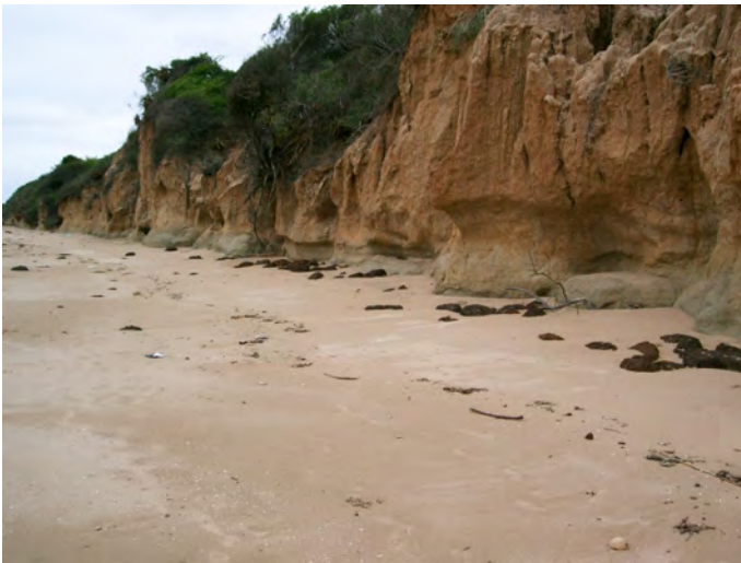
Figura 49. Outro aspecto da erosão costeira, na arriba, cerca de 3,4 km a SE da Ponta Maona. A unidade geológica exposta é a Formação de Ponta Maona, afectada por cavernas na base da arriba, onde a cor da unidade é cinzenta por ser mais rica em argila e mais preservada da erosão meteórica. Notar a quantidade de fragmentos de crostas ferruginosas escuras espalhadas na praia, por erosão da Formação de Ponta Maona. Fotografia de Ruben Dias (26°03'15,088''S; 32°37'02,185''E).
