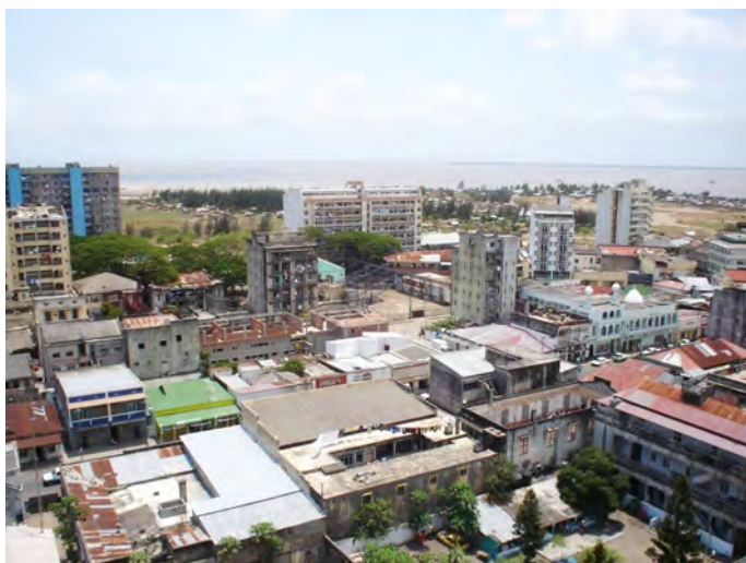
Figura 82. Edificado, na cidade de cimento, em mau estado de conservação.
