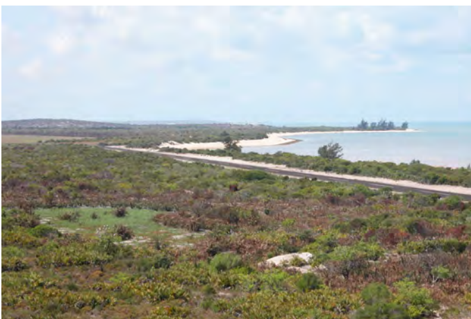
Figura 60. Pormenor da reduzida distância que separa a pista de aviação do bordo da duna frontal. Fotografia de Luís Rebêlo.
