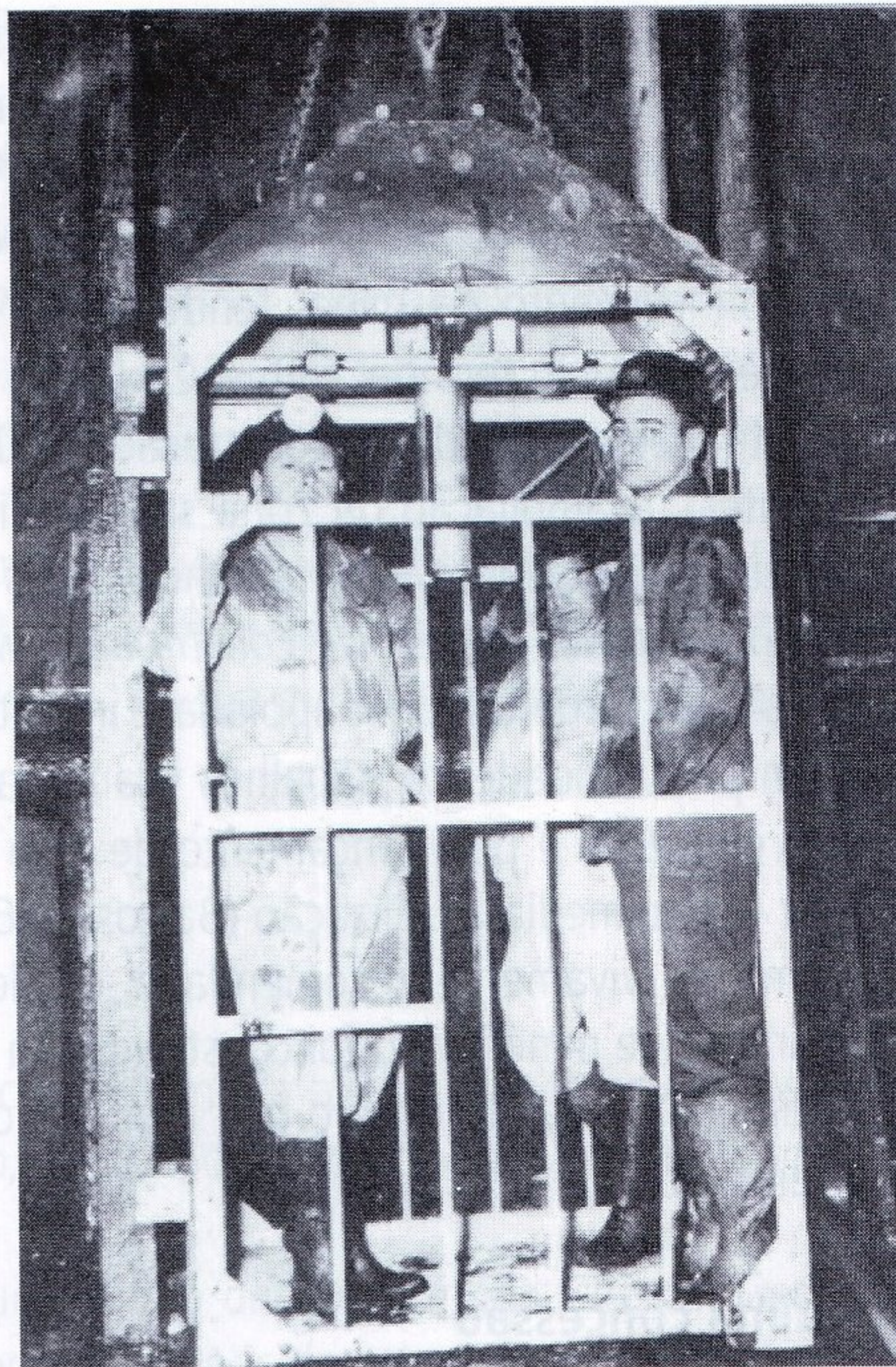
Figura 3. Jaula de transporte do poço S. Francisco com os engenheiros Barros e Araújo e um capataz. Foto S.F.M., s/d. Arquivo do IGM.
