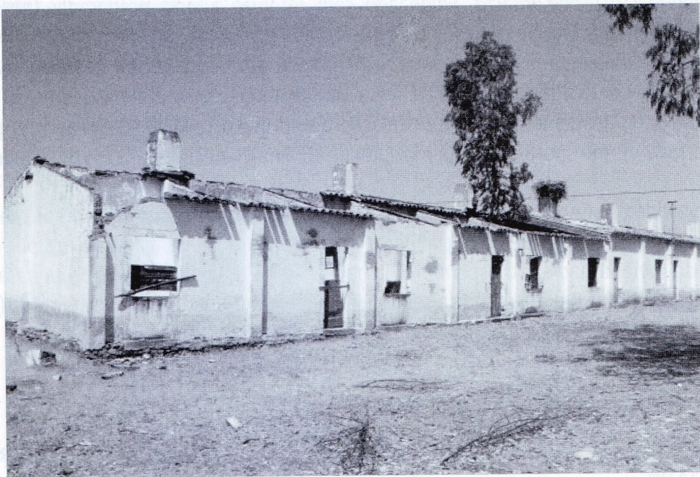
Figura 4. Vista parcial do bairro operário. Foto dos autores, 2002.
