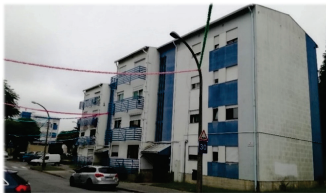
Figura 3 - Fotografia do edifício em estudo
