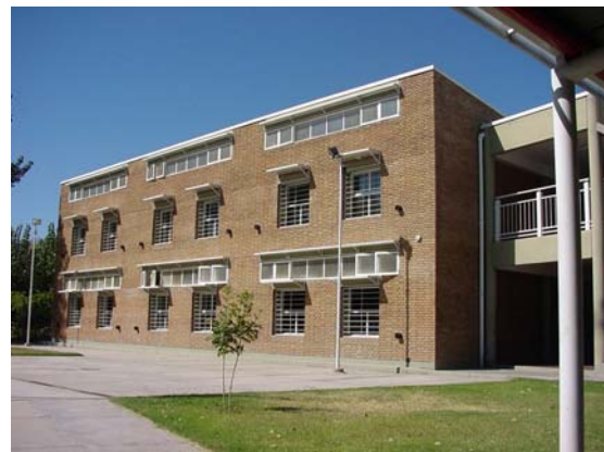
Vista Norte Bloque de Aulas.
