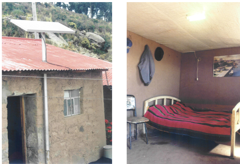
Figura N° 3 Las fotografías mostradas en esta figura reproducen detalles de casas rurales de la isla Taquile del lago Titicaca del departamento de Puno (3800msnm). La de la izquierda permite apreciar el grosos de los muros de adobe con que se construyen y ventanas pequeñas; la de la derecha muestra el interior de la casa, el dormitorio, y deja apreciar el falso techo. Muros gruesos, ventanas pequeñas y falso techo, proveen a la vivienda de mejores condiciones de confort respecto a la temperatura. Puede apreciarse también, el módulo fotovoltaico (izquierda) y la lámpara interior (derecha), partes componentes del SFD instalado.
