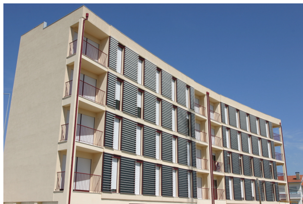
Figura 2.1- Vista do alçado sul do edifício
