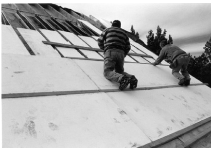
Figura 19. Colocación de la segunda capa de aislación en el techo, sin puentes térmicos. Espesor: 20 cm (15cm + 5 cm).
