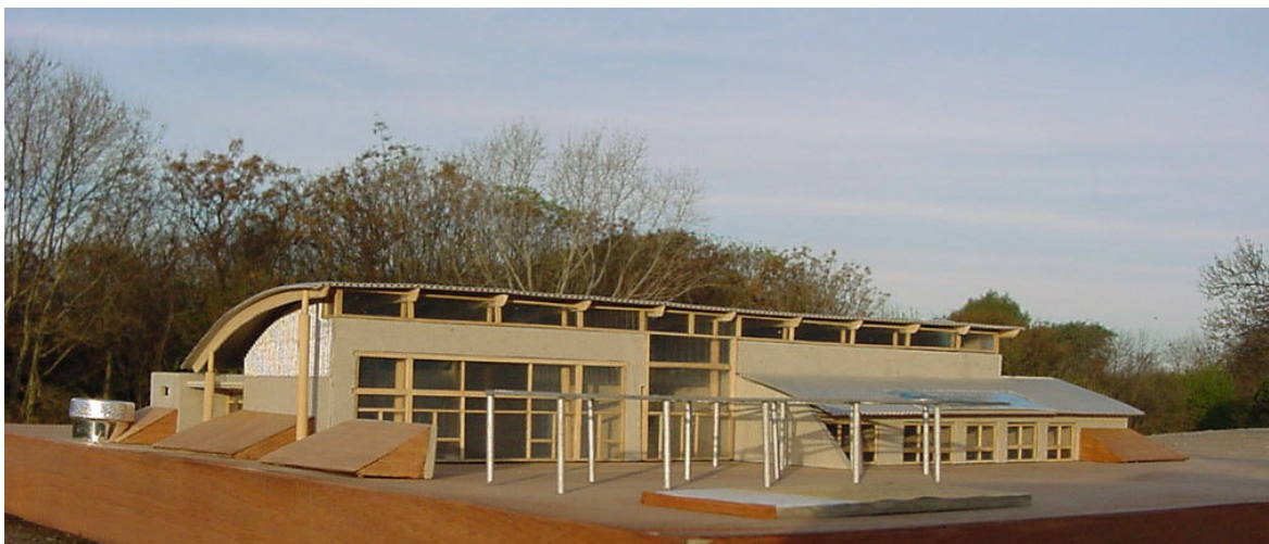
Figura 1. Fachada norte de la maqueta, vista desde el NE. El alero del techo ofrece protección solar en verano, mientras permite el acceso al sol en invierno.
