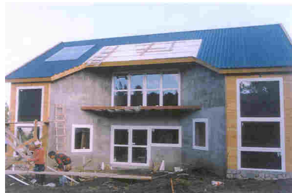
Figura 11. La fachada norte de la casa en construcción, con colectores solares y FV.
