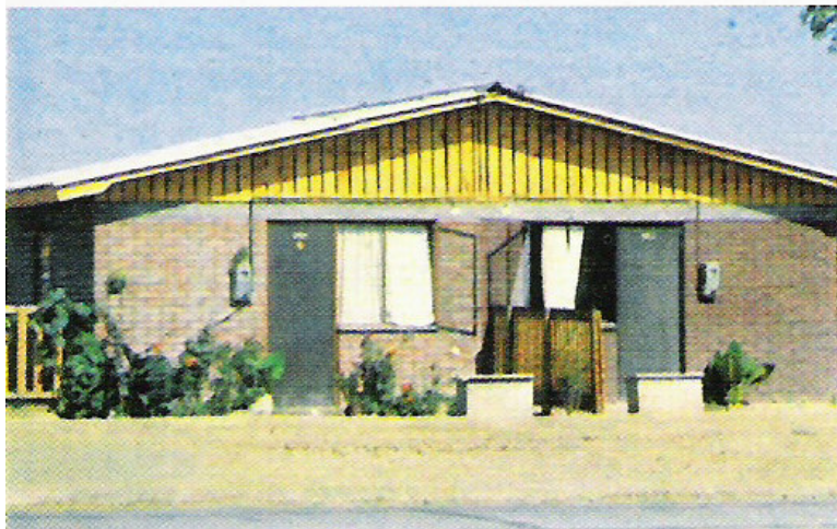
Figura 1: Vista frontal de vivienda en Población Los Carolinos, Puente Alto. Fuente MINVU 2004a
