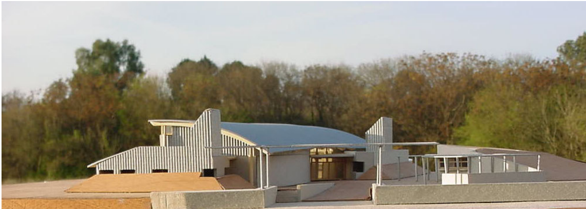
Figura 2. Vista desde el SO, la fachada oeste tiene limitadas aberturas, mientras la fachada sur incorpora elementos de protección del viento frío.
