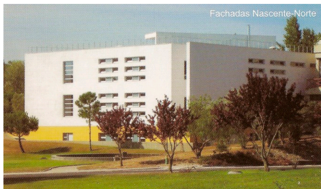
Edifício Solar XXI – Exemplo de edifício Bioclimático.
