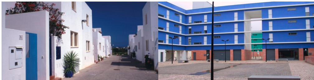
Legenda: 1992, As excelentes casas-pátio da Coop. O Nosso Piso, Conceição de Tavira, 70 hab., Arq. Pedro Serra Alves
