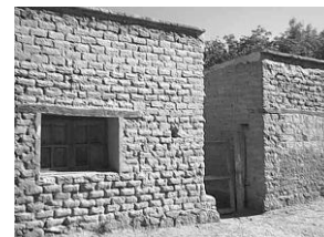
Figura 10: Mampostería de adobe típica .
