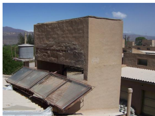
Fig. 9 Espacio público de juegos y colector calentador de agua (CSA) muy deteriorado
