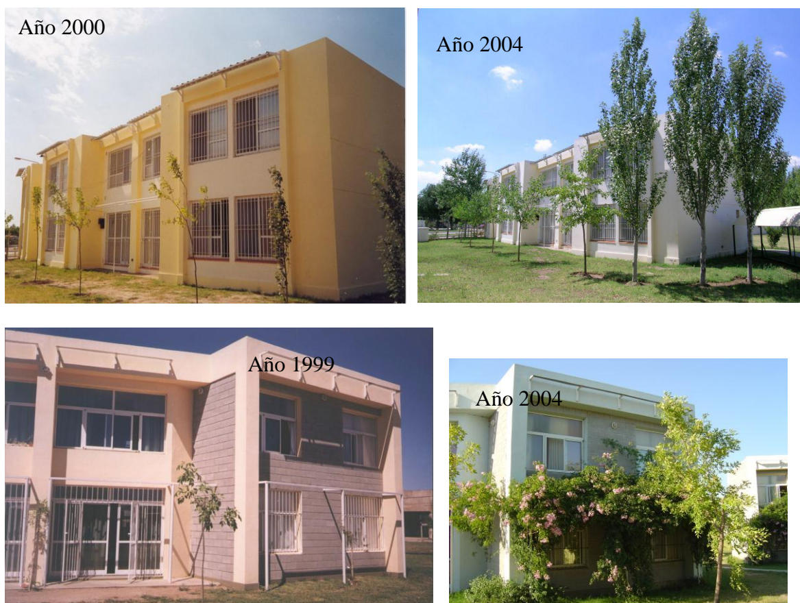
Figura 15: Imágenes de los edificios en el año de su inauguración y durante el año 2004
