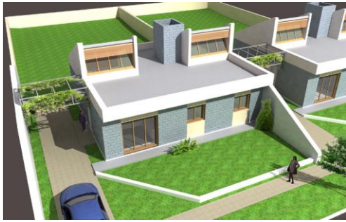
Figura 10: Vista norte de la vivienda mostrando las ventanas altas para ganancia solar directa
