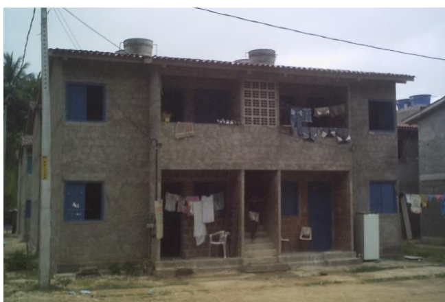
Figura 08: Edificação-tipo Fonte: Luana Moraes
