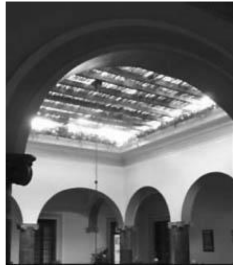
Figura 6. Patio con techo translucido y protección, Colima, Mexico
