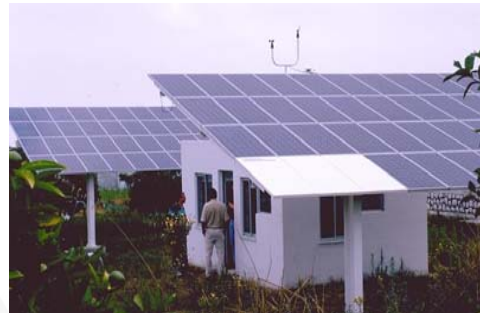
Bombagem de água
