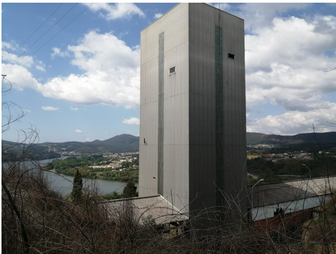
Figura 7 – Poço de Germunde II.
