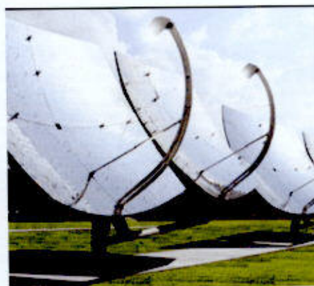
Figura 7 Sistema de CPV com possibilidade de aproveitamento da energia térmica | (foto extraído do website da Zenith Solar)
