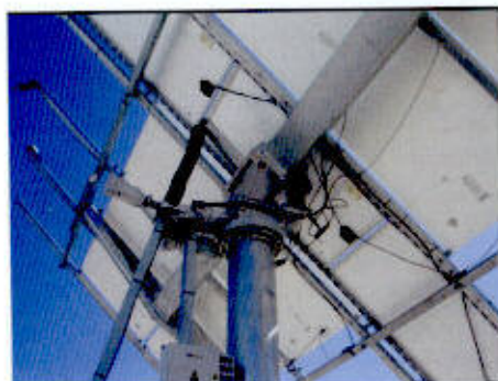
Figura 5 Sistema de seguimento do tipo pedestal | (foto do autor).
