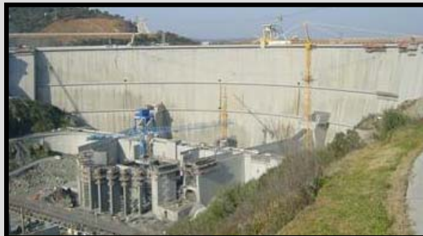
Barragem do Alqueva
