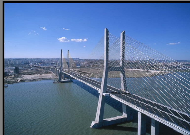
Ponte Vasco da Gama
