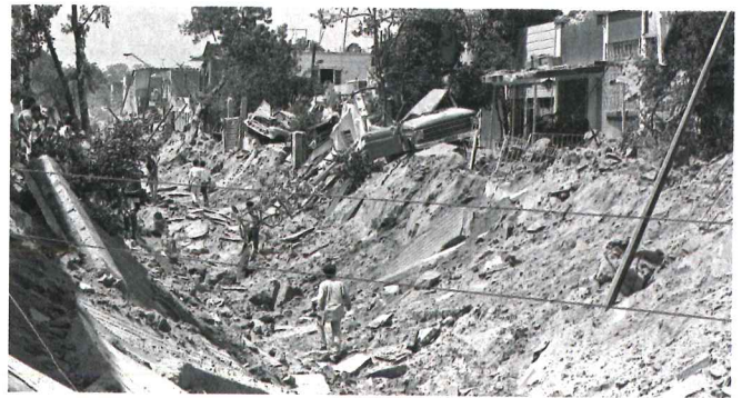
1992 – Guadalajara, México - Explosão da rede de esgoto
