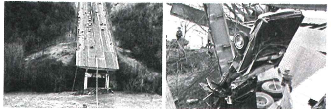
1967 – Ohio, Estados Unidos da América – O colapso da ponte de prata
