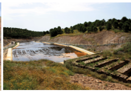
Tanques de cementação de cobre e pantanais de ribeira.
