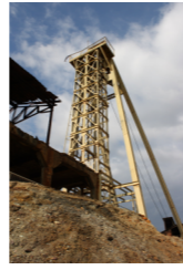
Poço nº 1 com 500m de profundidade. (3)
