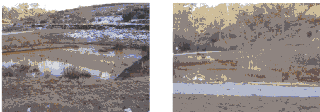
Fig. 7 – Wetland colector das águas de mina neutralizadas com plantas semi-aquáticas destinada à fitoremediação.
