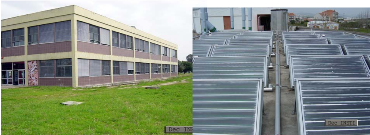
Fig. 2 – Edifício G do DER/INETI e colectores do tipo CPC utilizados no sistema DEC
