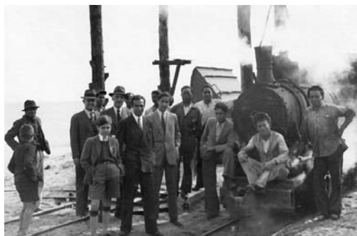
Fig. 6 – Grupo de trabalhadores aquando de uma visita rotineira de inspecção. Aut. desc., [194-?]. AHM – INETI
