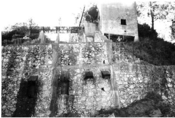
Figura 10 – A antiga central de britagem da Pedreira de Casal dos Touros
