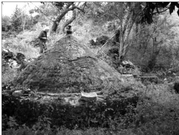
Fig. 6 – Poço de carapuça com púcaro
