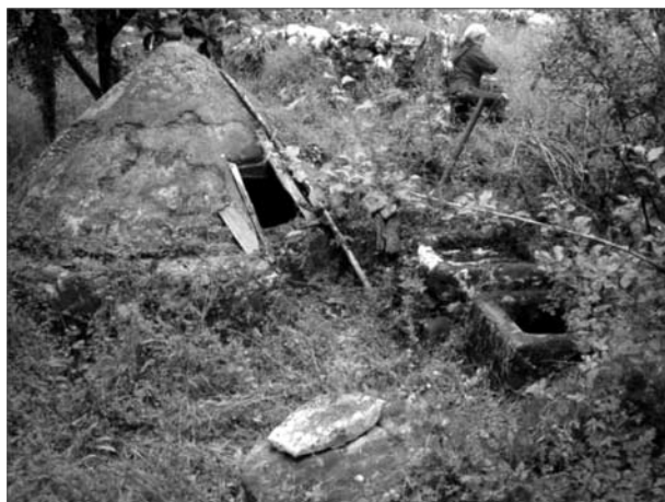
Fig. 7 – Poço de carapuça: «janela», pias e laje
