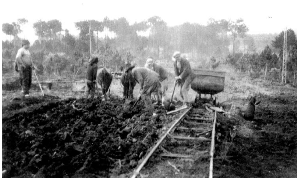
Fig. 3 – Construção da linha
