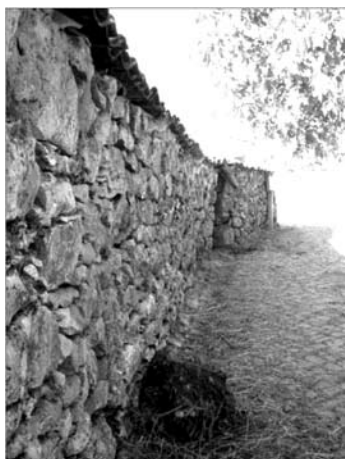
Fig. 3 – Muro com portão
