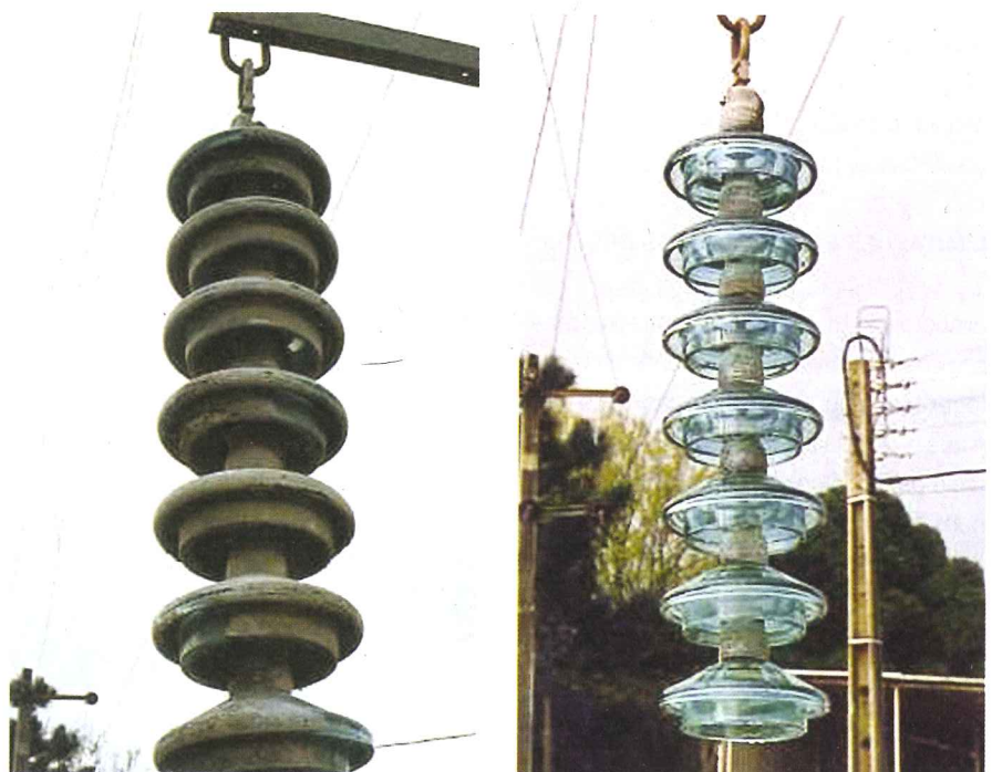
Figura 2 – Conjunto de isoladores em vidro antes e após limpeza pelo novo processo
