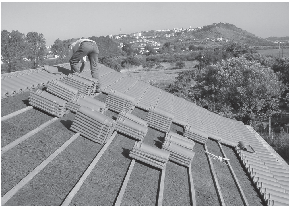
FIGURA 13.10: Aplicação de aglomerado expandido puro no isolamento de telhados.
