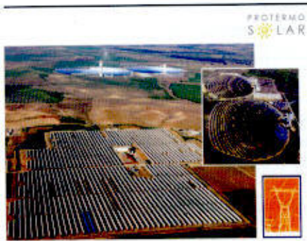
Centrais de Torre e Central Cilindro-Parabólico em Sevilha, Espanha [REF].
