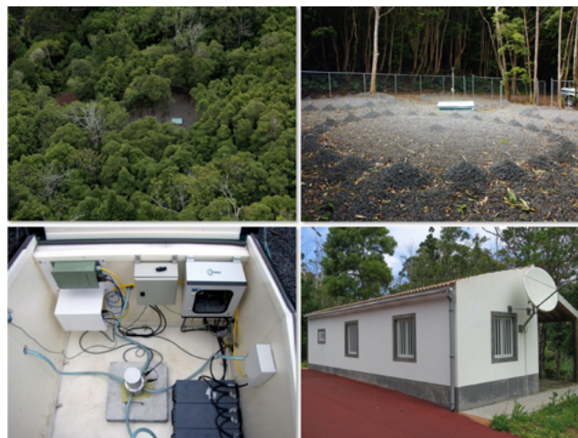
Figura 4. Detalhes da estação IS42. Figure 4. Details of the IS42 station.
