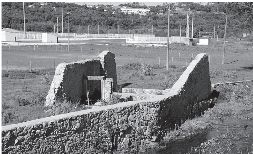
Figura 2. Ruína do antigo moinho do Pego dos Frades, no sítio da Cerca, Porto de Mós, onde se chegou a pensar instalar a tomada de águas para a central. Foto dos autores, 2015.
