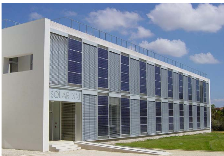
Figura 4.6. Fachada PV no Edifício Solar XXI - INETI
