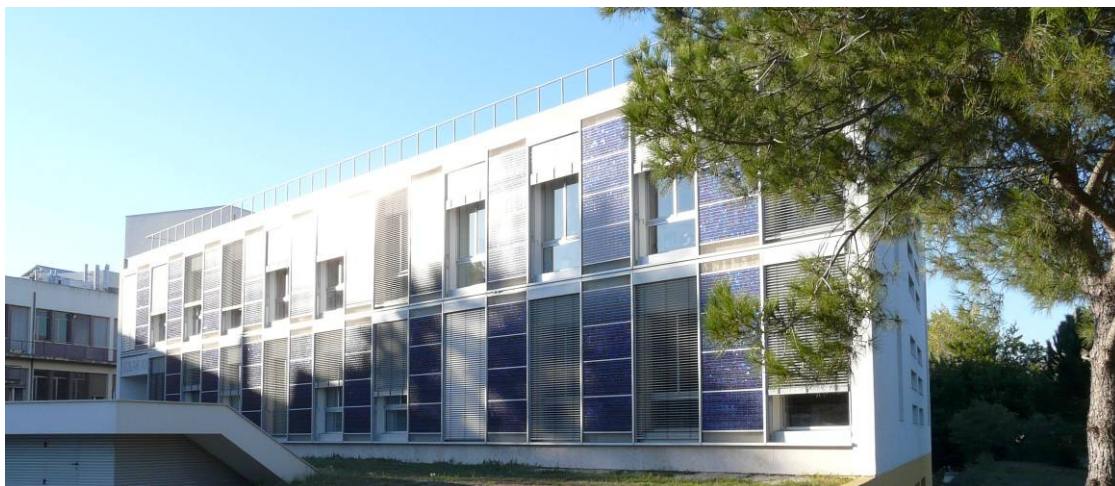
Figura 4.29. Sombras nos módulos provocadas pelo Edifício F e árvores próximas ao final da tarde (11/01/2007 16:12).
