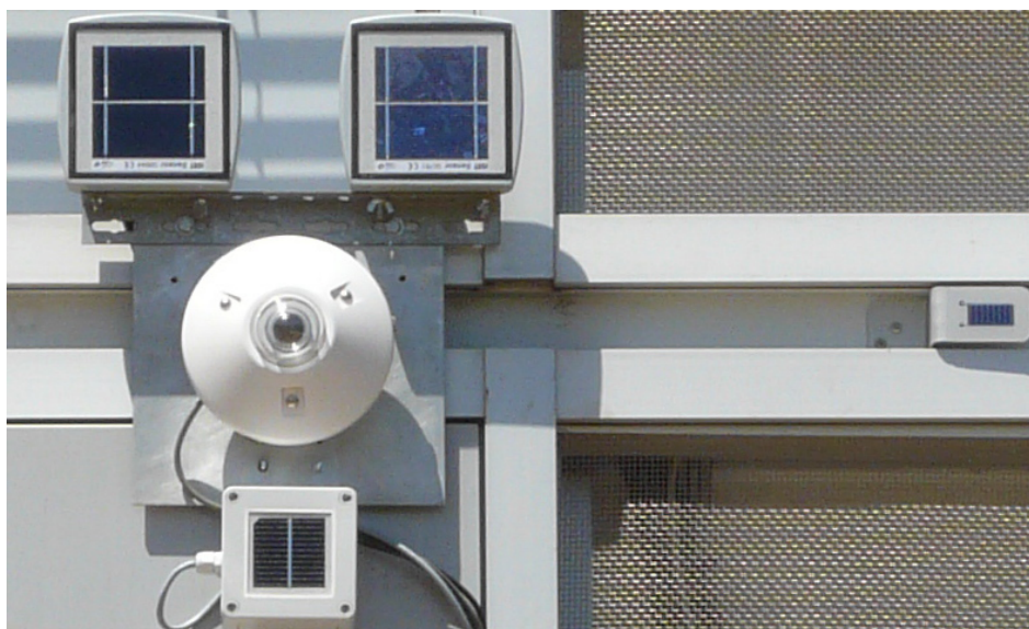
Figura 2.9. Sensores utilizados na medição da irradiância solar: piranómetro e células PV de diferentes tecnologias, instalados na Fachada do Edifício Solar XXI (montagem e foto do autor).
