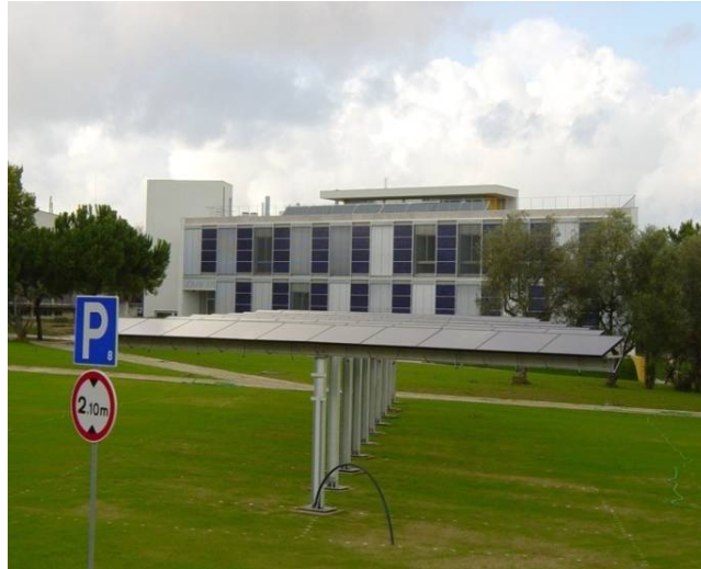
Figura VII.16 Edifício Solar XXI do INETI. Um exemplo de sistema ligado à rede integrado em edifícios.
