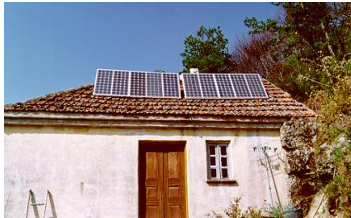
Figura VII.15 Exemplo de sistema autónomo instalado no Centro de Portugal.
