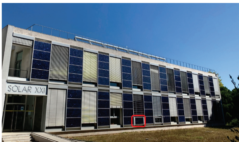
Fig.1 Edifício SolarXXI, integração protótipo BIPV-WS
