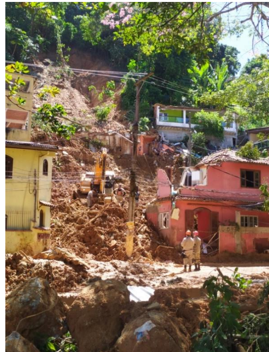
Figura 2. Local do desastre após a ocorrência. Vista frontal.
