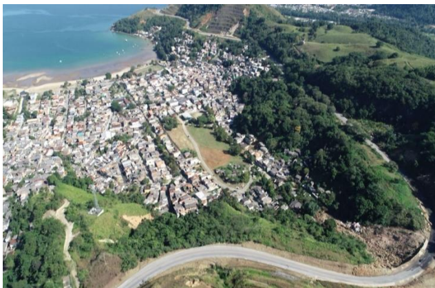
Figura 1. Vista panorâmica de Monsuaba cortados pela BR-101 e por deslizamentos e erosão.
