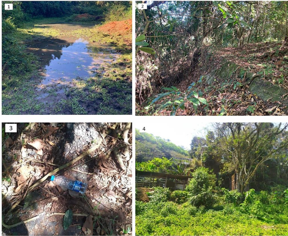
Figura 5. Área com evidências do passivo ambiental. 1) Área com acúmulo de água no topo da encosta; 2) degrau de abatimento da antiga área de britagem; 3) presença de asfalto e brita junto ao solo; 4) instalações da antiga usina de britagem.
