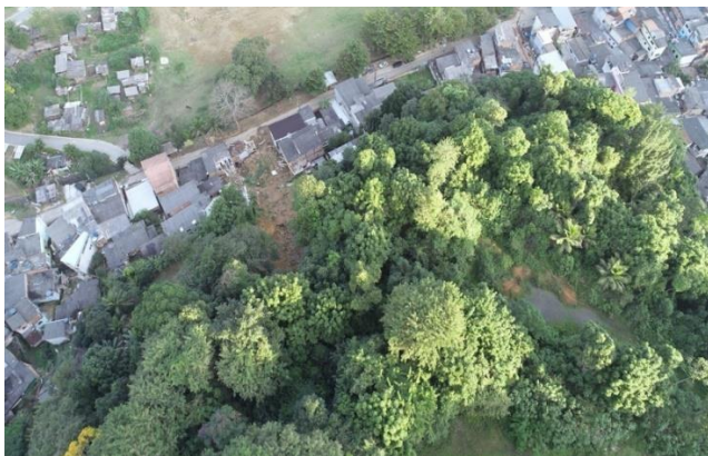
Figura 4. Imagem de drone da área afetada pelo deslizamento próximo a BR-101 no Km 468, onde mostra o lago formado próximo a crista de rompimento do talude.
